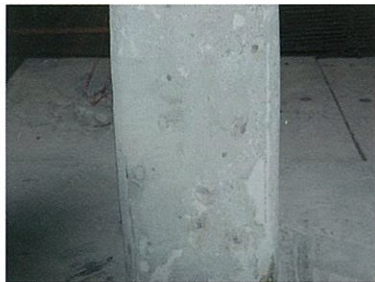
4 補修完了状況 表面研磨仕上げ
