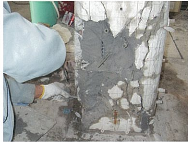
2 欠損部の修復状況 使用材料 IPH#600
