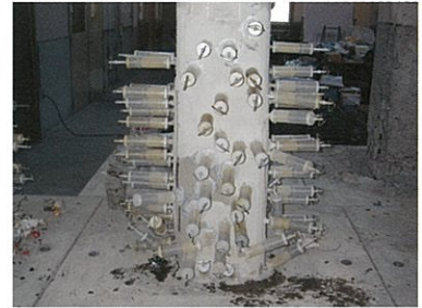
3 エポキシ樹脂低圧注入状況 マイクロカプセル 注入圧力 0.06N/mm 2
